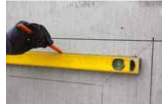
TRACER ENSUITE LES HORIZONTALES poursuivre par le tracé des modénatures horizontales
