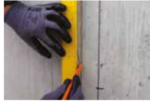
PRIORITÉS AUX VERTICALES démarrer toujours par le tracé des modénatures verticales
