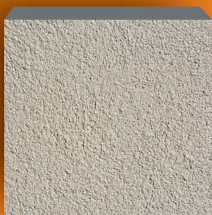
Support sain (absence de fissures et de décollement)
